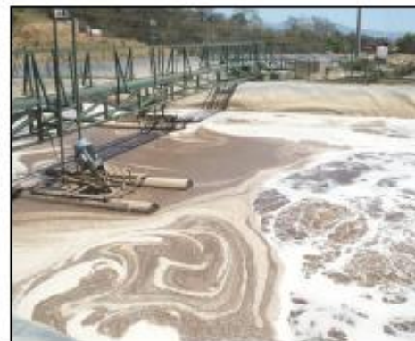
Fig 4. Laguna de lixiviados.
