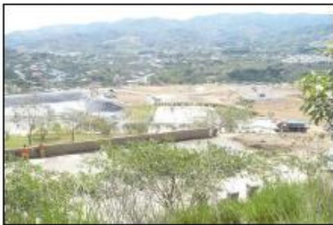
Fig 1. Vista panorámica del relleno.
