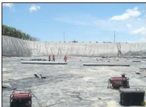
Fig 7. Celda en construcción.
