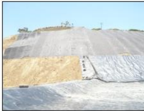
Fig 8. Celda en construcción.
