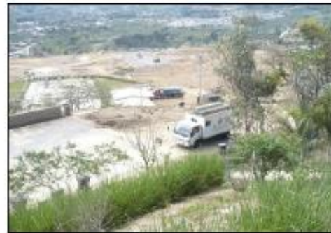
Fig 2. Vista panorámica del relleno.
